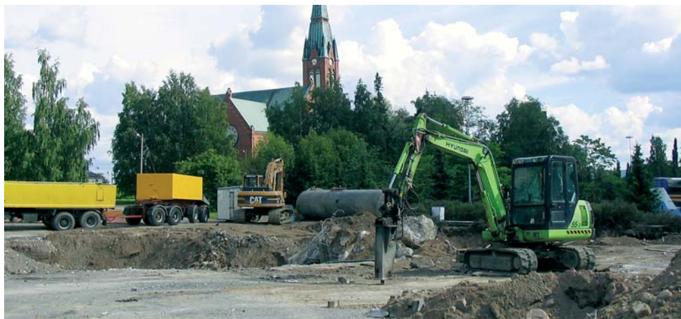
Entisen jakeluaseman maaperän kunnostusta Forssan keskustassa.
